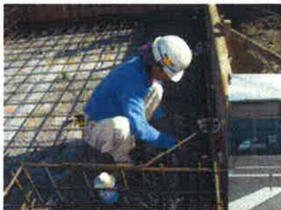
住宅の設備工事
