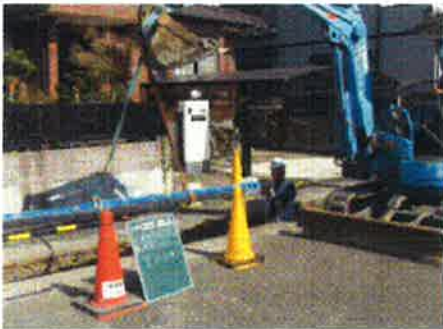
道路の水道本管工事
